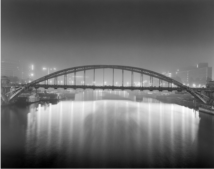
Viaduc d'Austerlitz with the fog rolling in
